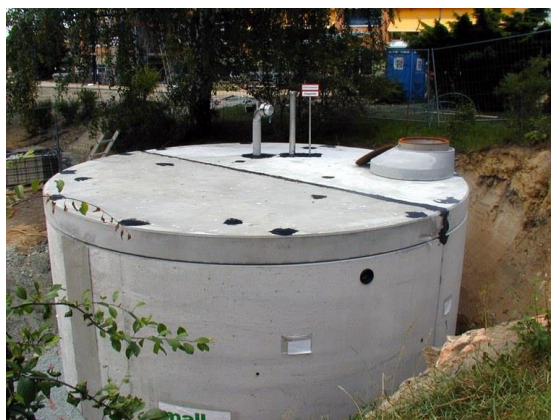
Abbildung 46 Unterirdischer Löschwasserbehälter
