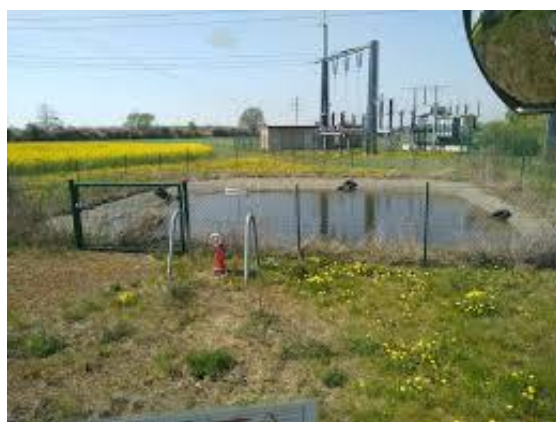
Abbildung 49 Feuerlöschteich mit Saugstelle
