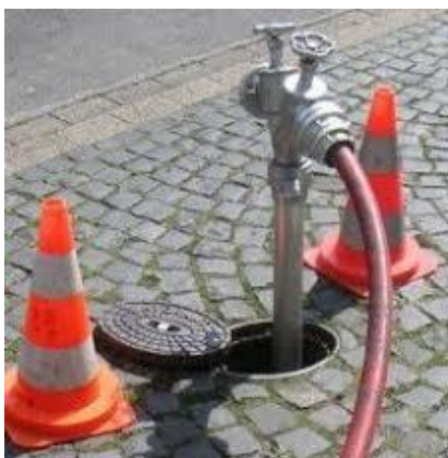
Abbildung 45 Unterflurhydrant mit Standrohr
