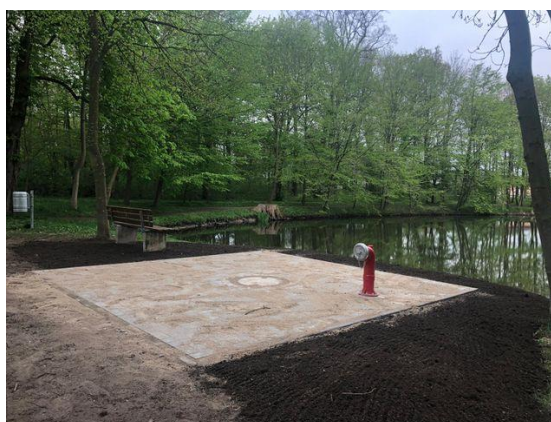
Abbildung 50 Entnahmestelle am offenen Gewässer
