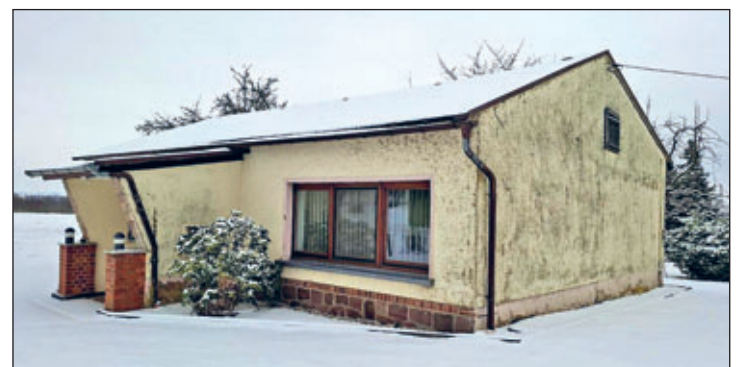
Das Kulturhaus in Höfchen bekommt dankte des Regionalbudgets 2026 eine neue Heizung und einen frischen Fassadenanstrich.
